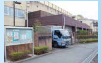
▲ 小学校敷地内の分館と図書館巡回車
