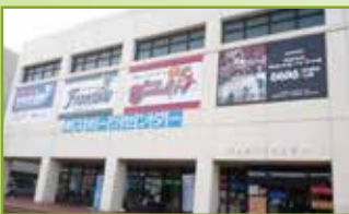
▲ 幸スポーツセンター
