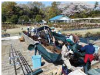
▲ 防草シート張りの作業
